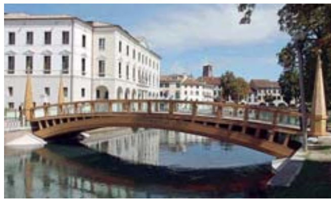
In centro Le transenne sul ponte San Francesco. Sotto, l'università
